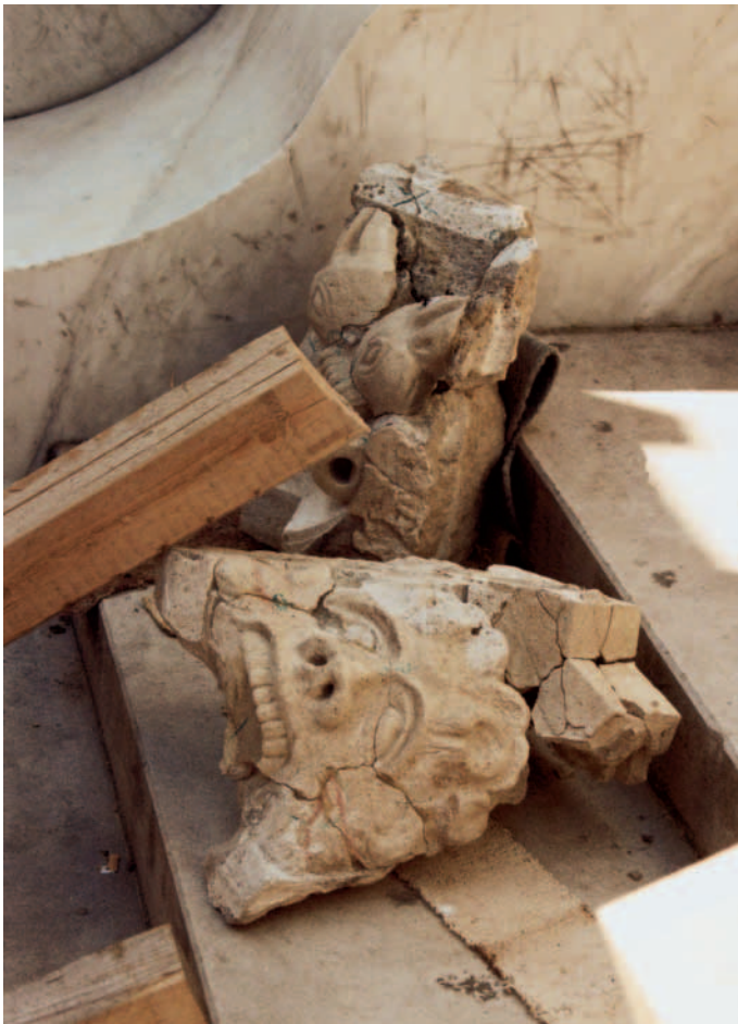
Die irreparable Bauzier wird ausgebaut und durch originalgetreue Kopien ersetzt.
